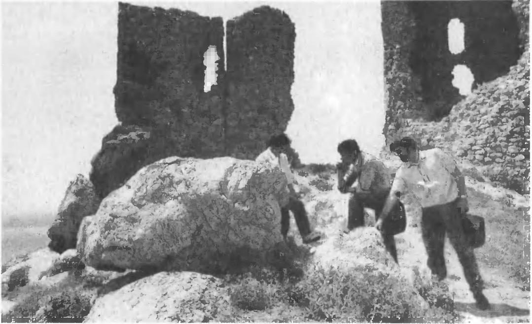
*Руины цитадели и верхней башни крепости Чембало со следами сейсмических разрушений (расщелина на стыке кладки, обрушение юго-восточного сектора круглой массивной башни). Вид с востока.*
